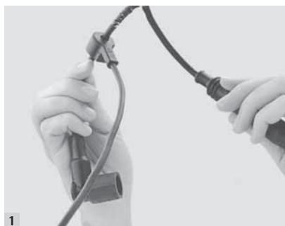
1 Retirez simplement le câble défectueux. Eenvoudig de defecte kabel verwijderen.
